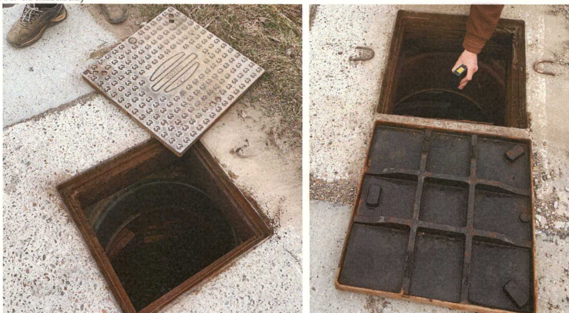
Fig. 11 Rame și capace carosabile montate la reabilitare drum
