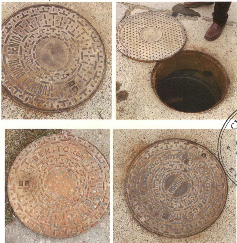
Fig. 10 Rame și capace necarosabile montate în carosabil
