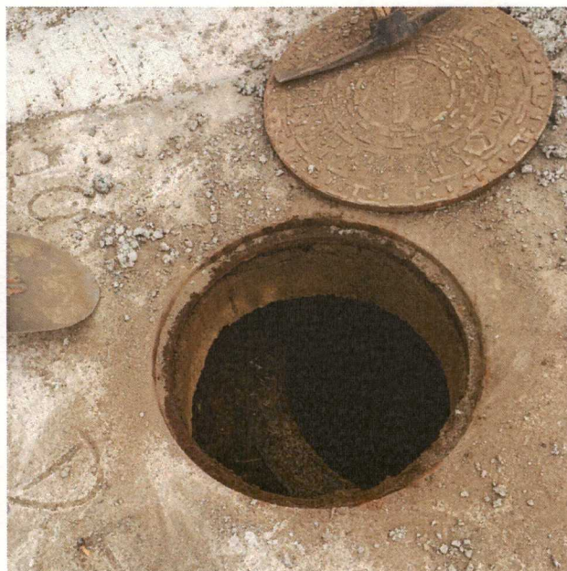
Fig. 3 Cămin CM 221 blocat cu beton și placa deplasată
