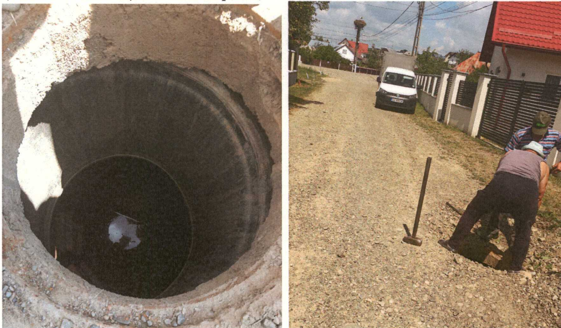
Fig. 9 Tronsoane decolmatate și cămine descoperite
