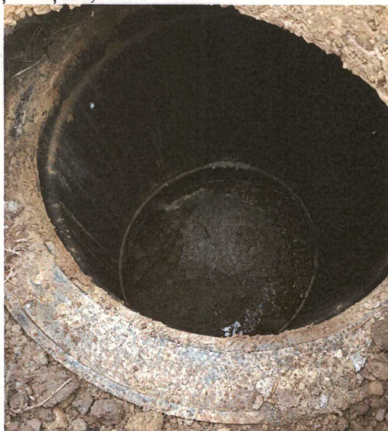
Fig. 3 Cămin CM 221 blocat cu beton și placa deplasată
