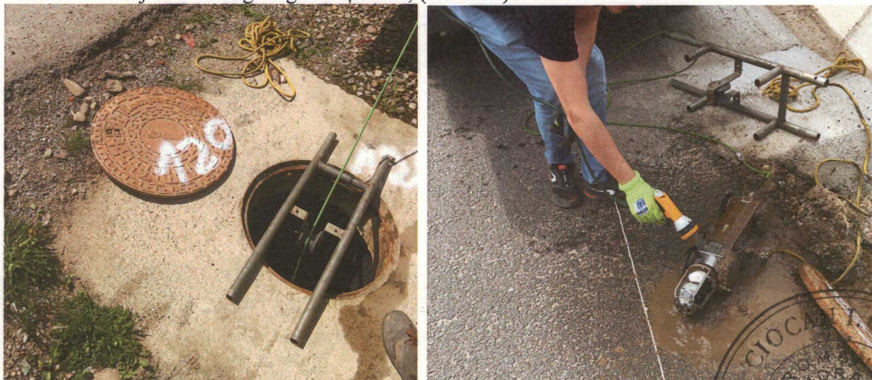
Fig. 8 Inspecție video canalizare
