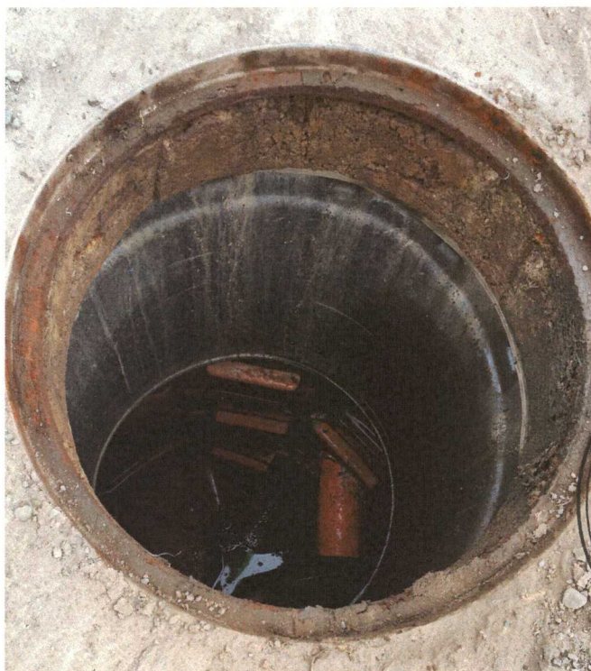
Fig. 6 Racord canal în CM 141
